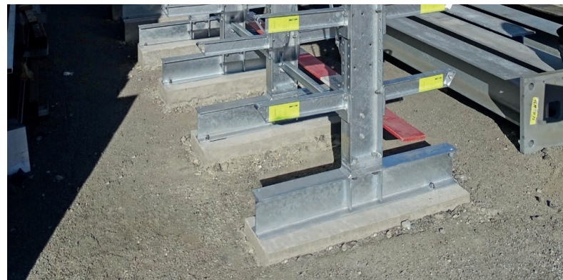
Streifenfundament
